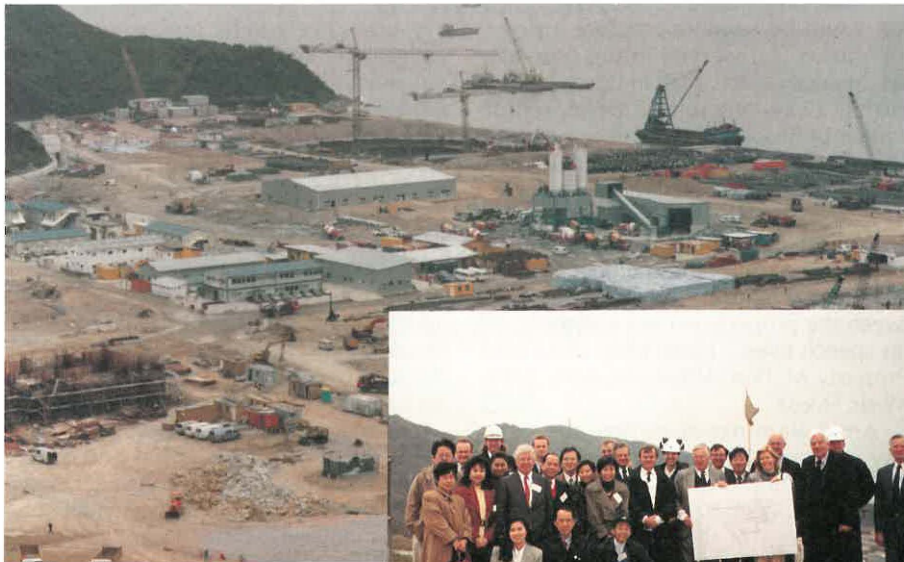
Work in progress on the site. 正在進行的地盤工程
